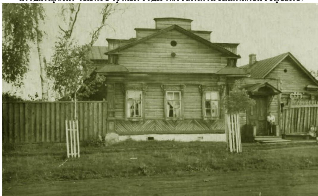
Алатырь. Дом Александра Ивановича Тюбукина на Водопроводной улице (ныне ул. Жуковского)
